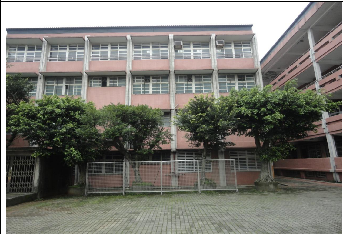
101 年 12 月修剪工藝大樓前榕樹完成後
