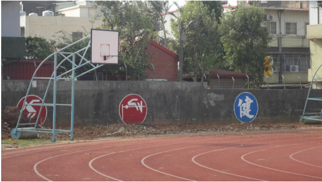
100 年圍牆橡樹移除施作後
