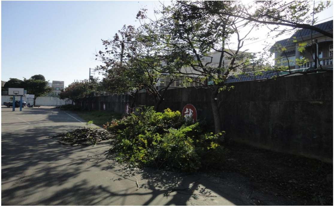
103 年 12 月圍牆旁台灣欒樹施作前
