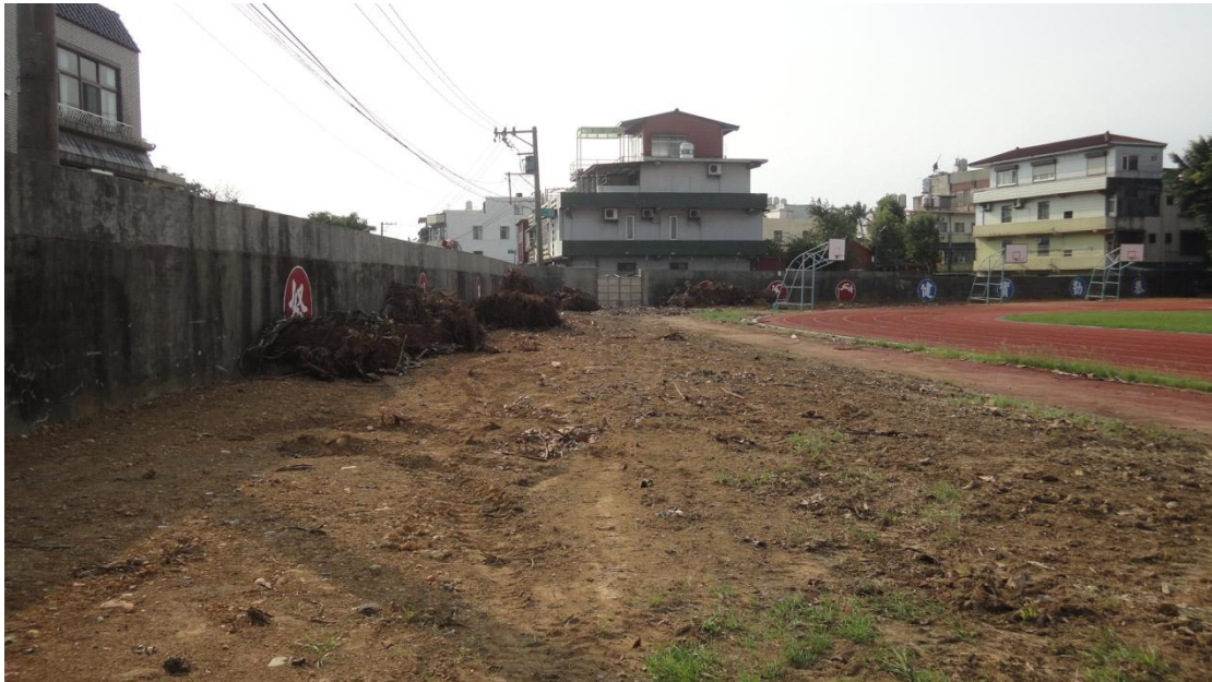
100 年圍牆橡樹移除施作後
