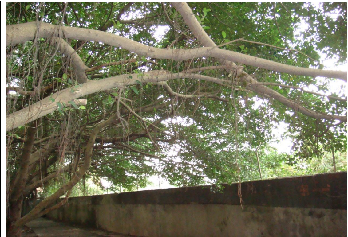
101 年 12 月修剪停車場旁圍牆校樹施作前
