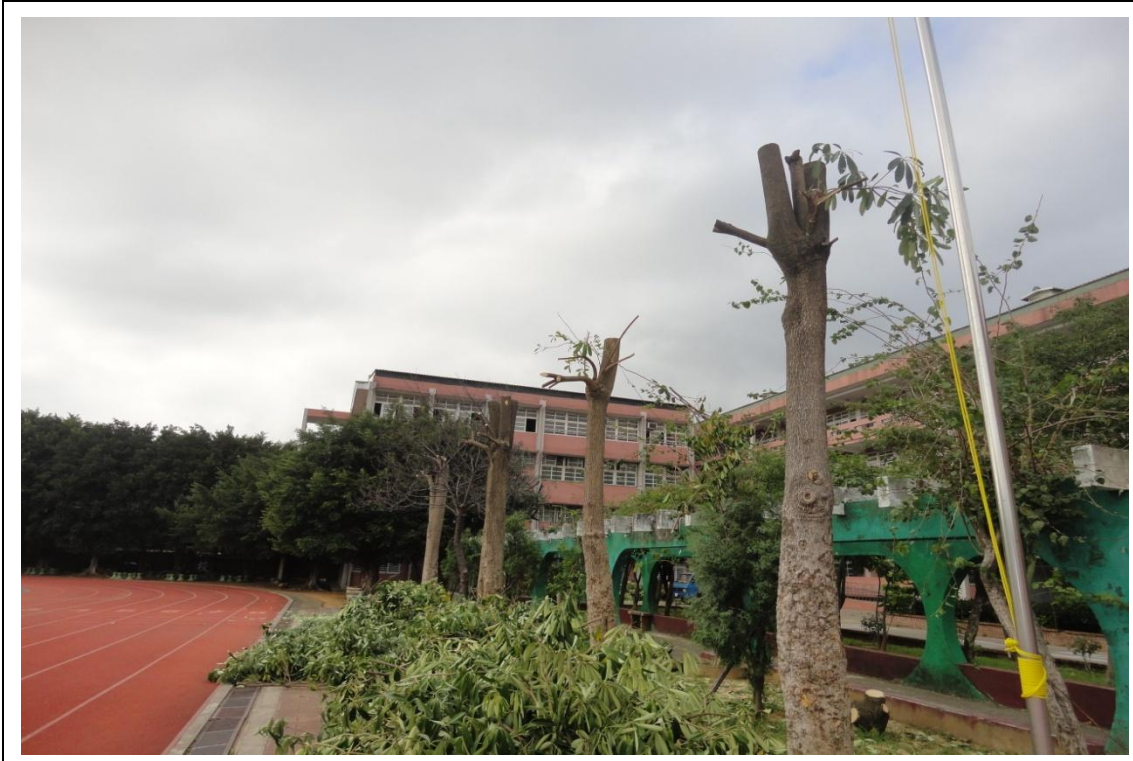
101 年 12 月修剪操場黑板樹完成後
