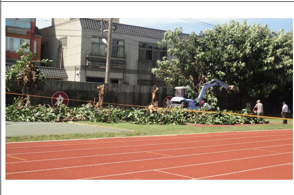
100 年圍牆橡樹移除施作中
