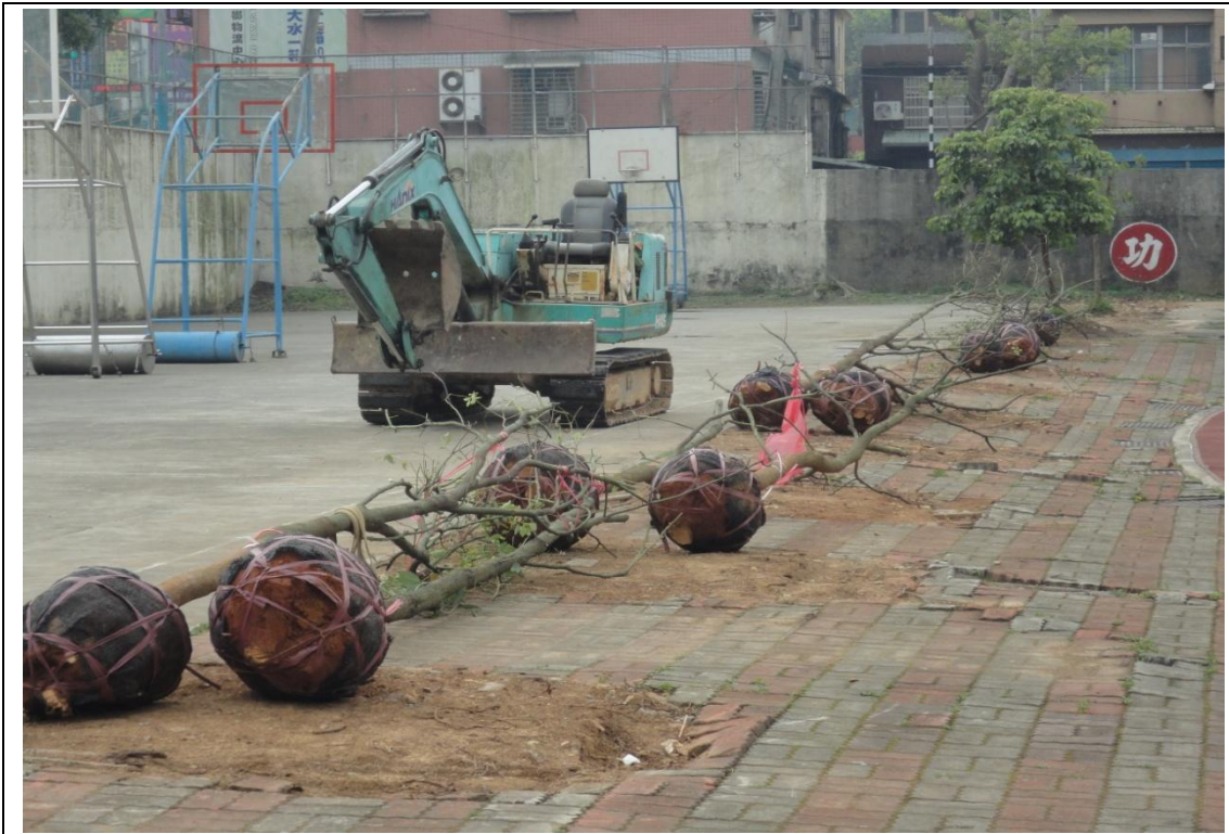
103 年 3 月移除籃球場橡樹改種台灣原生種樟樹施作中
