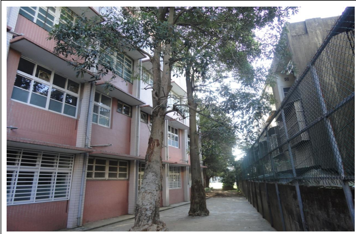
103 年 12 月移除工藝大樓後方黑板樹施作前
