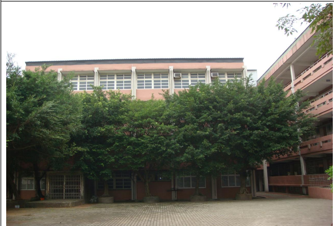
101 年 12 月修剪工藝大樓前榕樹施作前
